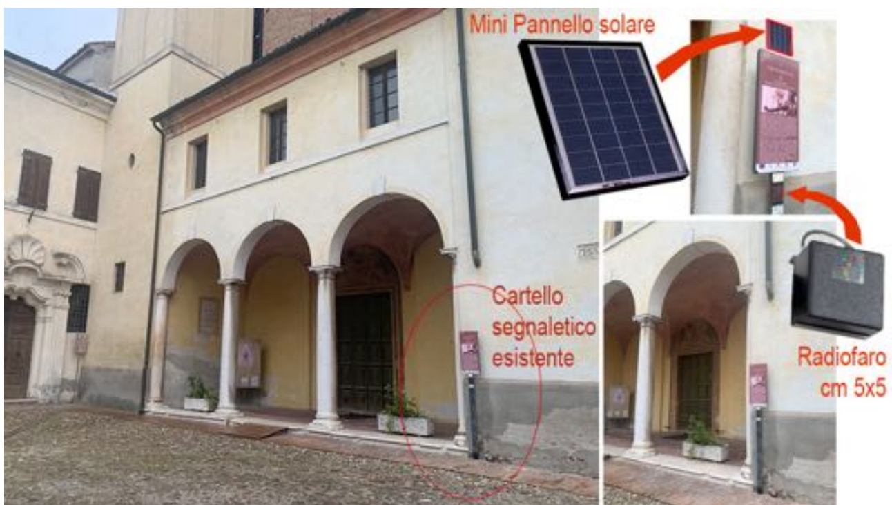
Esempio di installazione autonoma non invasiva dei Radiofari su elementi esistenti (es. chiesa Incoronata)
